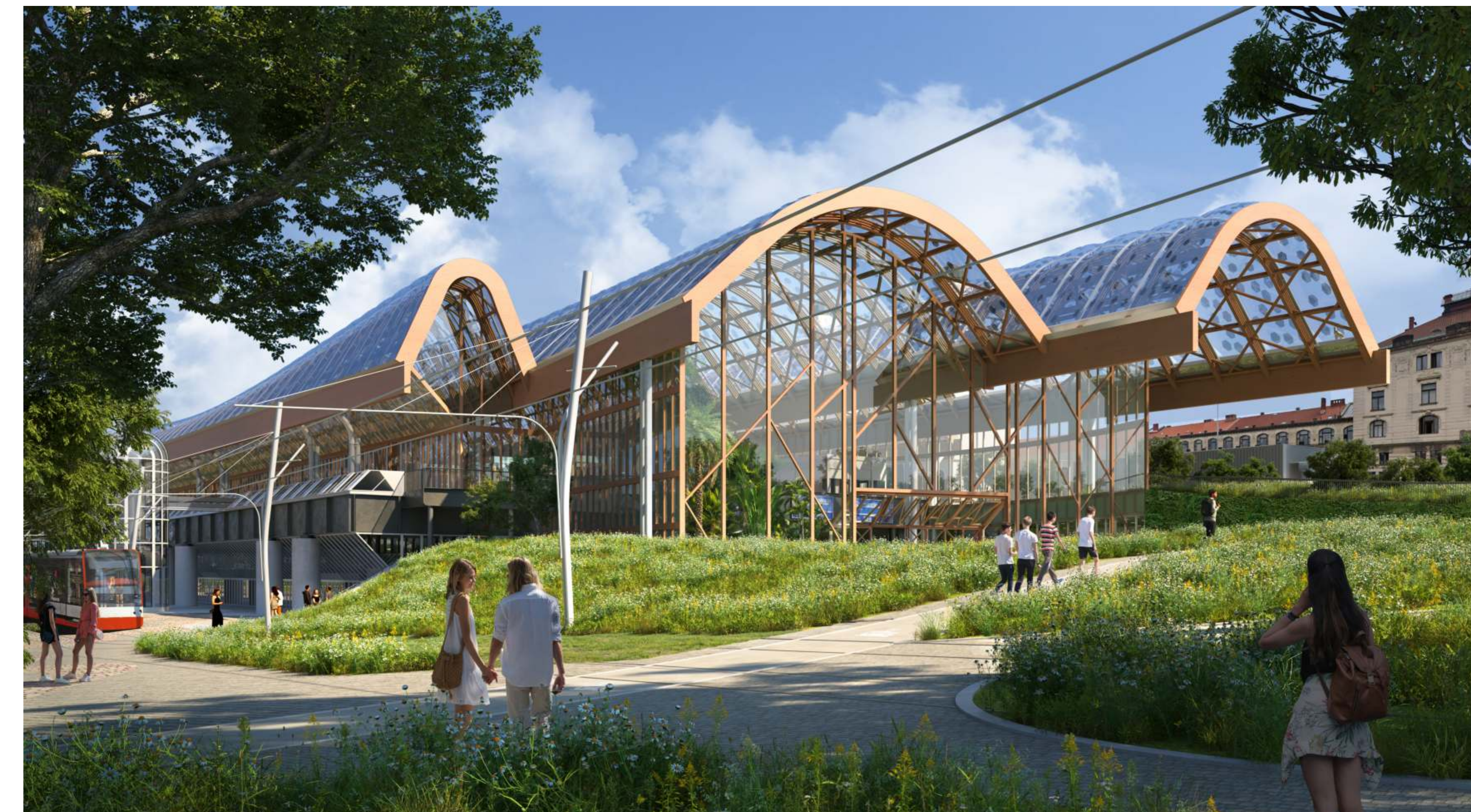
South entrance: In this view we can see the integration of the building in the landscape and with the park. After the demolition of the ramps and the side facades of the existing building, a new 15 meters tall access hall is created. The new landscape guides people directly into the new entrances. To the left, we can see how the existing building keeps the structure and front facade to the park, where the new tram stop is located. Jiní pohled: V tomto pohledu je vidět začlenění budovy do krajiny a parku. Po demolici ramp a bočních fasád stávající budovy vznikne nová 15 metrů vysoká přístupná hala. Nová krajina navádí lidi přímo k novým vstupům. Vlevo můžeme vidět, jak se stávající budova zachová strukturu a čelní fasádu do parku, kde se nachází nová tramvajová zastávka.
